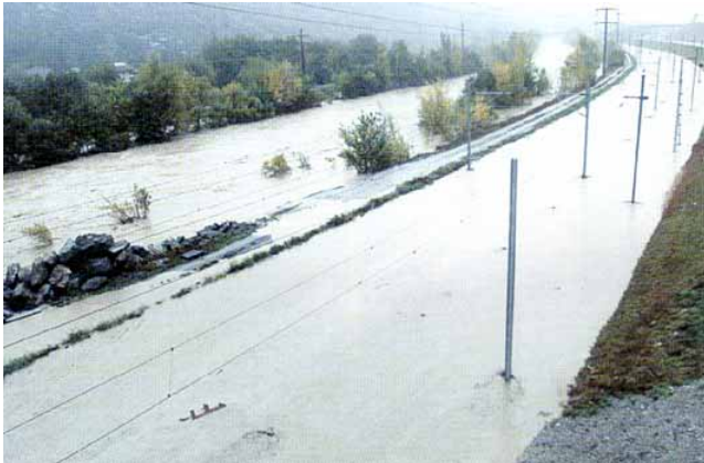
Rhonefloden overskyllede BVZ- og SBB- skinneområdet mellem Brig og Visp den 15. oktober 2000.
